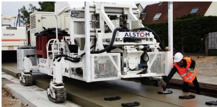
Questo processo costruttivo costituisce una modalità di tracciamento e posa meccanizzata che consente di installare le piste più velocemente rispetto ai metodi convenzionali, migliora le condizioni di sicurezza e la pulizia del cantiere, riduce i disturbi ambientali anche in termini di impatti sonori e polveri oltre,
