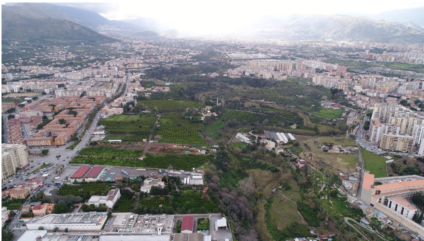
Area di intervento sul fiume Oreto
