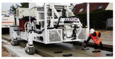
Questo processo costruttivo costituisce una modalità di tracciamento e posa meccanizzata che consente di installare le piste più velocemente rispetto ai metodi convenzionali, migliora le condizioni di sicurezza e la pulizia del cantiere, riduce i disturbi ambientali anche in termini di impatti sonori e polveri oltre,
